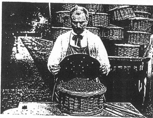
**L**A POSE DU COUVERCLE EN CARTON. — Un couvercle mobile en carton solide et souple, percé de trous, est posé et bien appliqué sur les Cassis. Il ne reste plus qu'à le fixer solidement.
